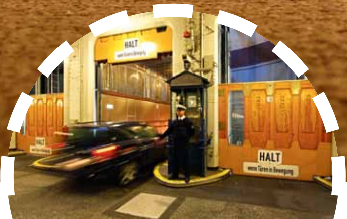
Ob Passant oder Pkw-Fahrer: Wer durch den Elbtunnel möchte, muss mit einem der Aufzüge in den beiden Schachtgebäuden fahren. Rund 30 Sekunden benötigen die Fahrstühle für die 23,50 Meter Höhenunterschied zwischen Straße und Sohle.
