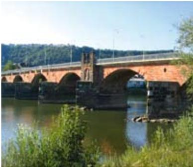
Brücke der einzige feste Moselübergang zwischen Metz und Koblenz. 1689 von französischen Truppen teilweise gesprengt, wurde sie zwischen 1716 und 1718 wieder aufgebaut. Bis heute hält die etwa 200 Meter lange Brücke, die aus acht Kriesegmentbögen und sieben Pfeilern besteht, dem Verkehr stand. Fünf Pfeiler stammen noch aus der Römerzeit.
